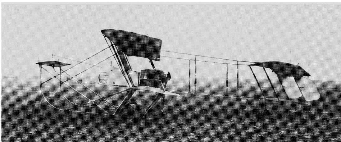
**Biplan MF-2 à moteur Renault 60 ch (1910) dérivé du MF-1 de 1909. (Cliché S.H.A.A.).**
